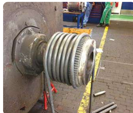
Nagrzewanie połączeń Montaż i demontaż
