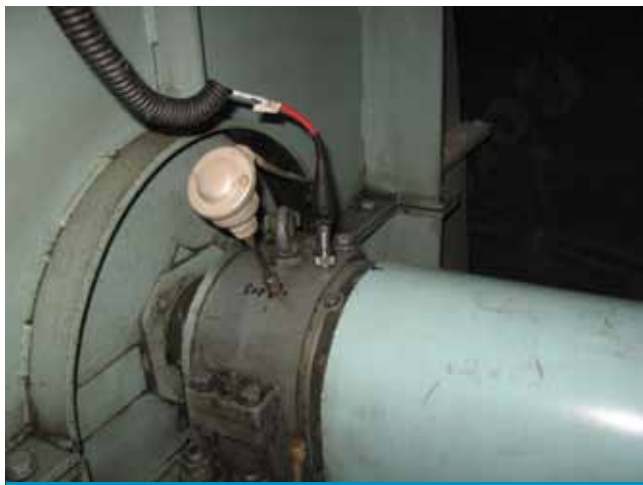
ZDJ. 1. Czujnik drgań umieszczony na oprawie łożyska
