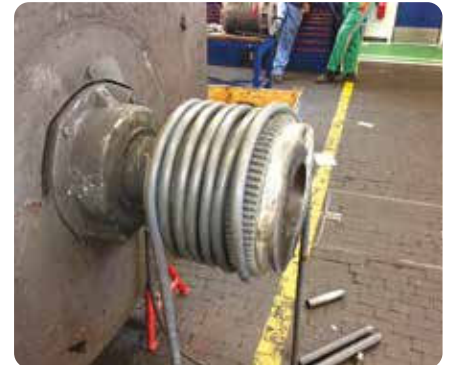
Nagrzewanie połączeń Montaż i demontaż
